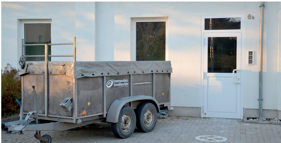
IM NOVEMBER NOCH BAUSTELLE: Die künftige KV-Praxis in Mügeln
